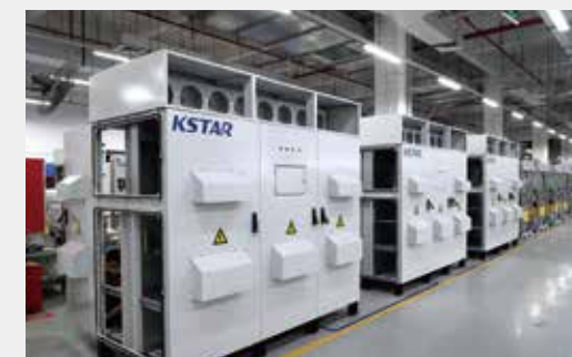
Warsztat montażu PV
